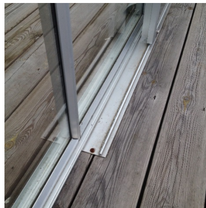
Billedet viser, at den yderste køreskinne til døren går 56 mm længere ud end bundprofilen
